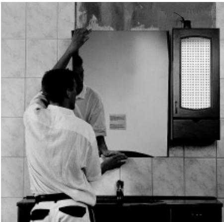
Lustro można teraz przymocować do ściany bezpośrednio do warstwy kleju do glazury lub przy pomocy kleju silikonowego (należy upewnić się, że użyty klej do glazury może być stosowany również do luster).
